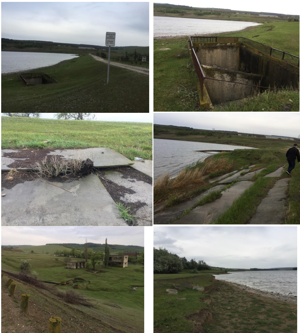
Lacul de acumulare „Cneazevca”,
