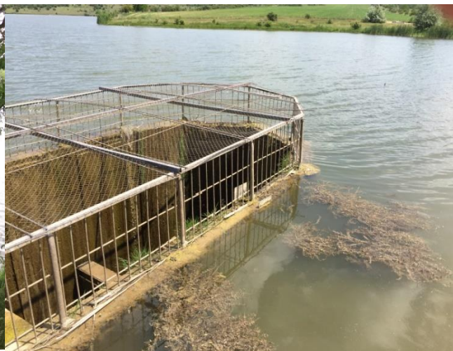
Lacul „Badragii Vechi,, Construcția hidrotehnică (barajul și descărcătorul de suprafață)
